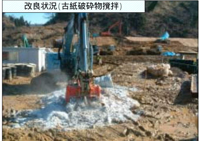
改良後4時間で大型ダンプトラックが走行可能
