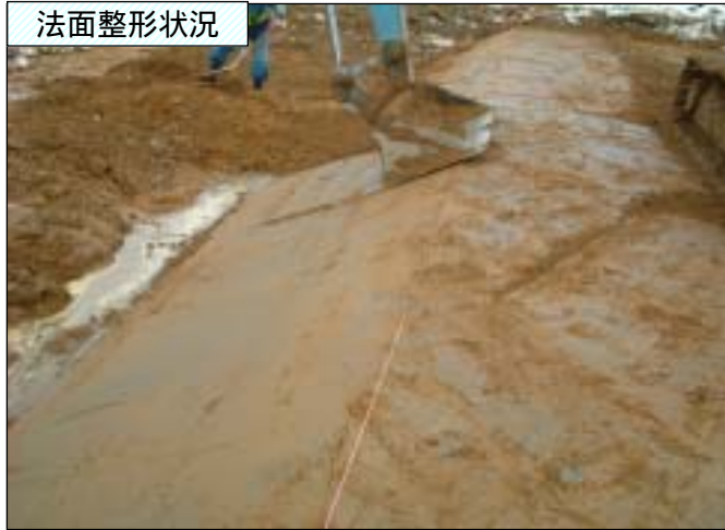
改良土締固め
