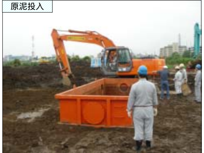
万能土質改良機による混合
