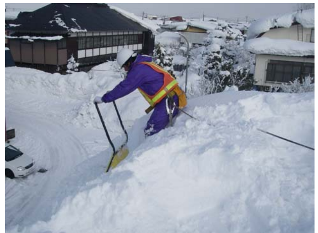
2階の屋根に雪崩留めがあるものの命綱をつけ慎重に作業開始。
