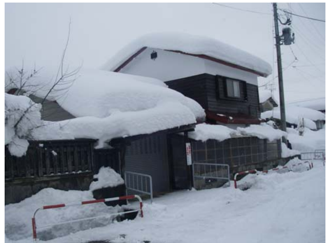
雪下ろし前のお宅。2階部分以上に1階部分の積雪がスゴイ！！
