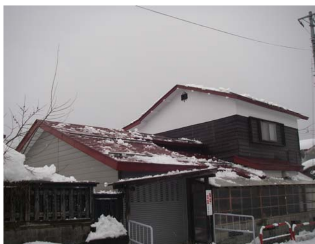
雪下ろし終了後の屋根。 今日からは 安心して休めるとの手紙が・・
