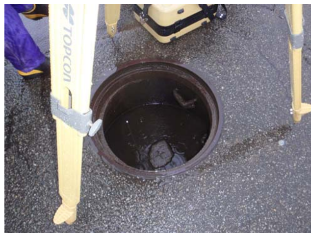
マンホールの中に基線東端の標石が見える
