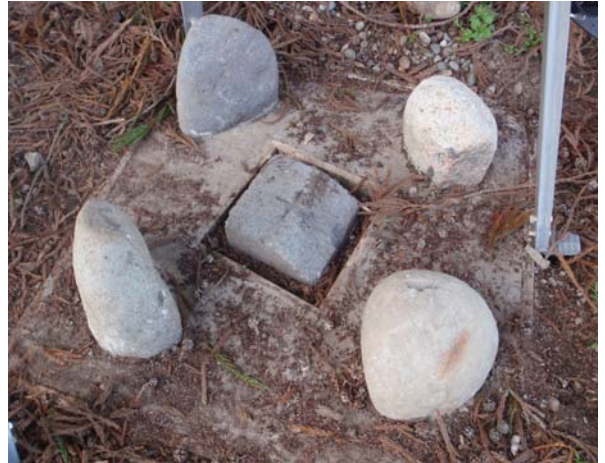
基線西端の一等三角点標石。標石の天盤を地盤高とした。(標高 145.76m)
