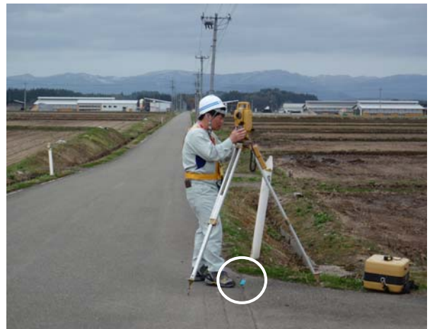
設置した基準点(○印)にトータルステーションを据え付ける。
