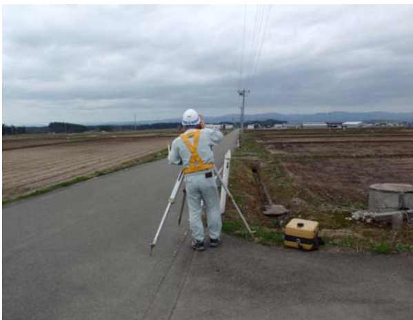
遠方のターゲット(ミラーポール)マンをトランシーバ(無線器)で誘導する。
